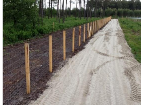
Exemple de clôture
