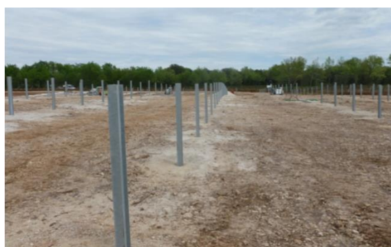
Exemple de réalisation de pieux battus
